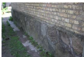
Фота 5. Прыклад падмурка з бутавлага камяню па вул. Свядлова, 106
